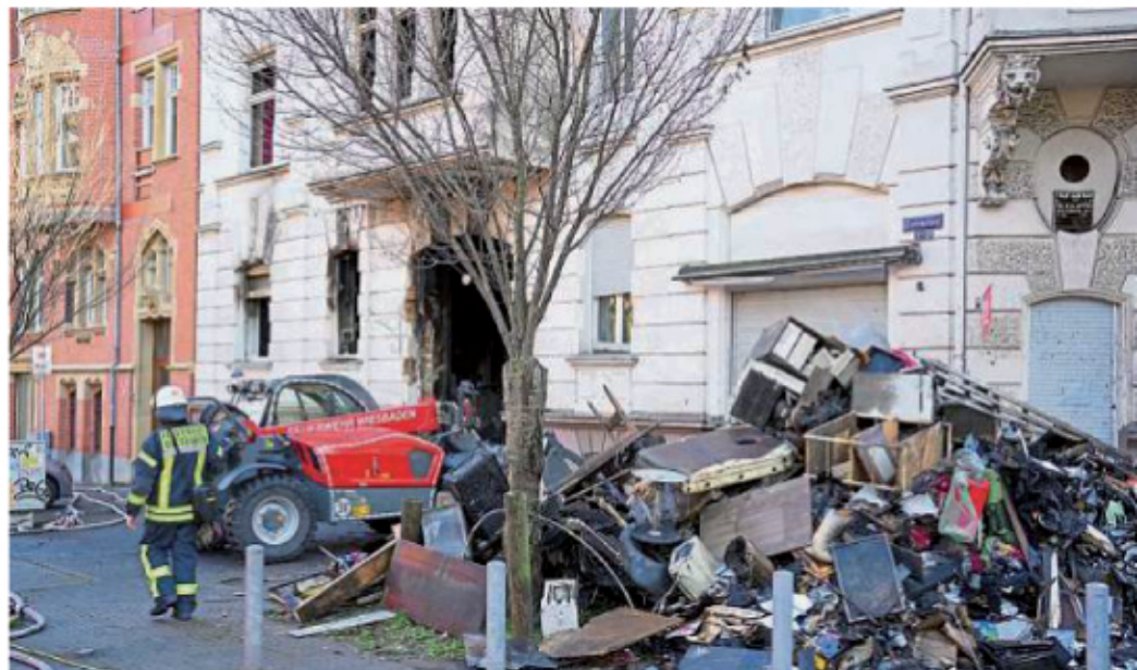
Bei den Nachlöscharbeiten müssen die Einsatzkräfte die Brandwohnung ausräumen. Dazu benutzen sie auch einen speziellen Radlader.
